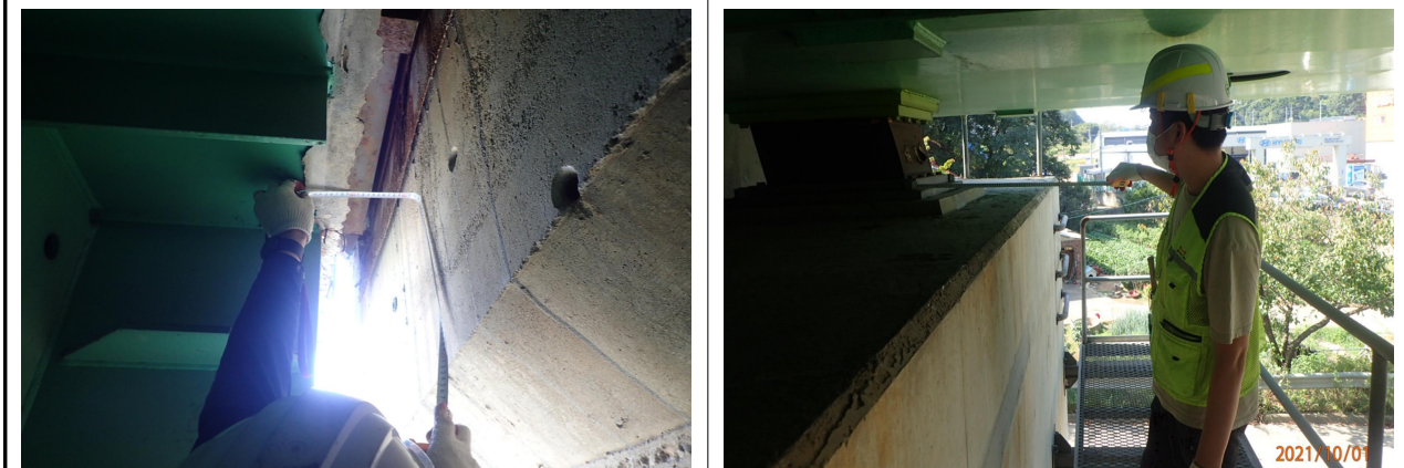
점검로를 이용한 외관조사
