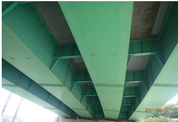
STB 거더 외부 전경
