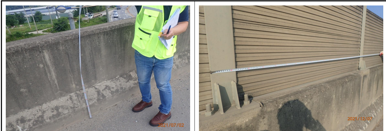
도보를 이용한 외관조사
