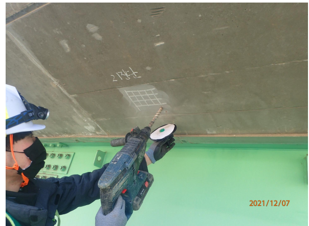
탄산화깊이 측정 전경
