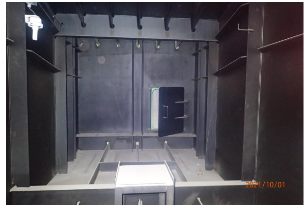
STB 거더 내부 전경
