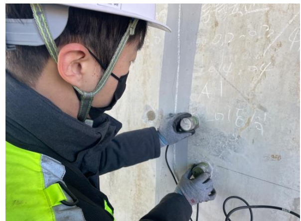
균열깊이 측정 전경
